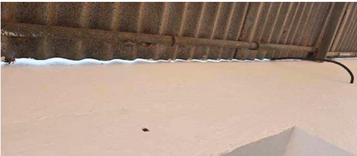
*Figuras 8 y 9 – Encuentro entre chapa de cubierta y muros laterales*
