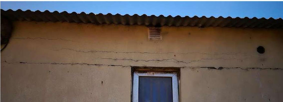
*Figuras 10, 11 y 12 – Dintel y encadenado superior*
