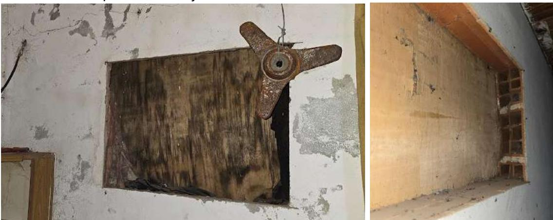
*Figuras 16, y 17 – Vanos tapiados en muros laterales*
